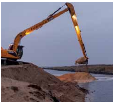
Den langarmede gravemaskine gik i gang med at lukke indløbet.
