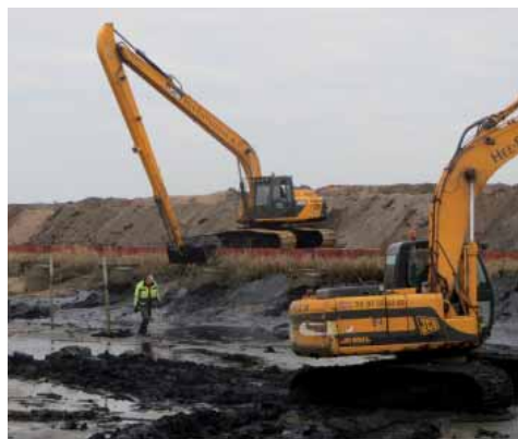
Da havnen var tømt for vand og broer, gik maskinerne i gang med at skovle slammet op i "gryden".
