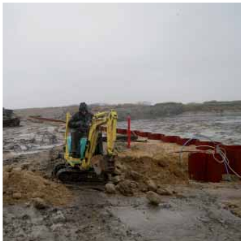
Arbejdet med renoveringen foregik i al slags vejr. Her er Erling i gang ved slæbestedet.
