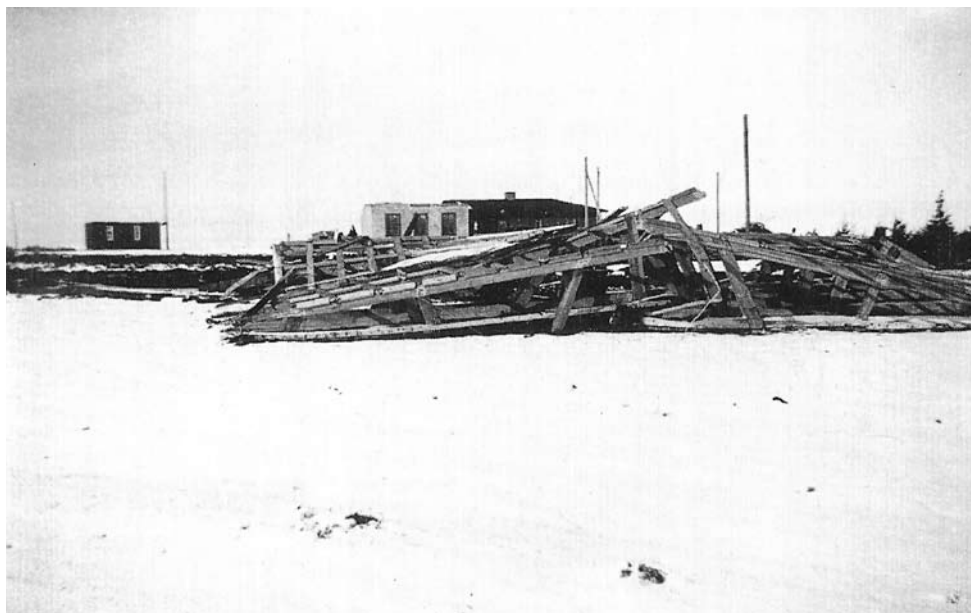
Ødelæggelserne på Skavenhus efter vinterstormen i 1951.
